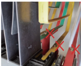
铜排有裸露带电螺钉
