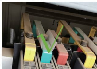
增加绝缘帽和绝缘隔板
